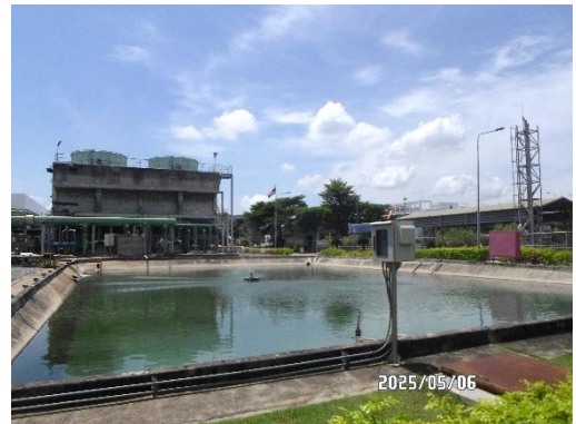
รูปที่ 12 บ่อพักน้ำทิ้ง (Holding Pond) ของโครงการ ขนาด 500 ลูกบาศก์เมตร
