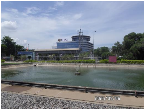
รูปที่ 12 บ่อพักน้ำทิ้ง (Holding Pond) ของโครงการ ขนาด 500 ลูกบาศก์เมตร
