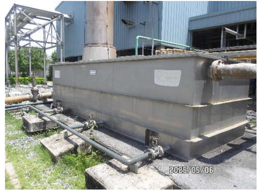
รูปที่ 11 ระบบ Neutralization System และระบบ Oil Separator
