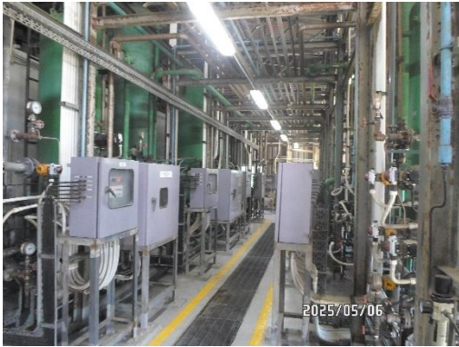
รูปที่ 11 ระบบ Neutralization System และระบบ Oil Separator
